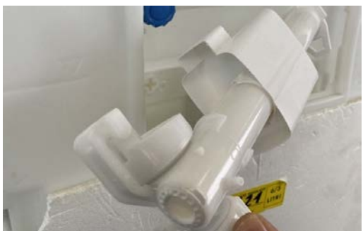
Neues Füllventil einsetzen.
