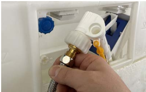
Füllventil mit Panzerschlauch herausnehmen.
