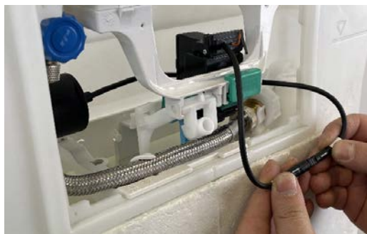
Kabel vom Batteriemodul an die Elektronik anschließen.
