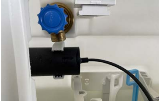
Batteriemodul in Halter für Batteriemodul einklippsen.
