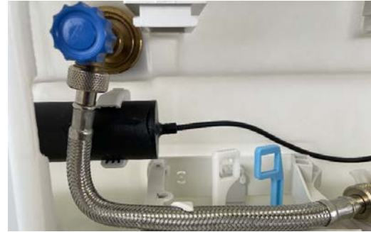
Panzerschlauch Füllventil an Eckventil anschließen.
