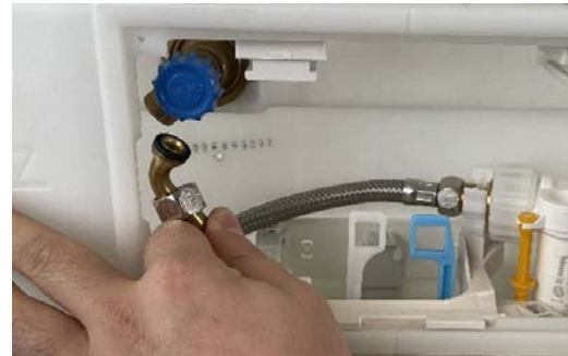
Schließen des Eckventils und Demontage Panzerschlauch.
