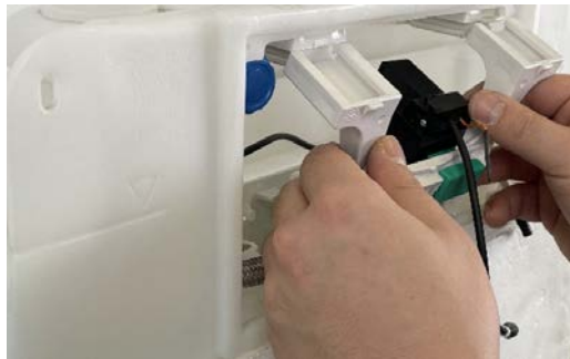
Umlenkbügel einsetzen.
