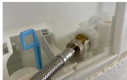
Füllventil auf Lagerbock mit Füllventilhalter montieren.
