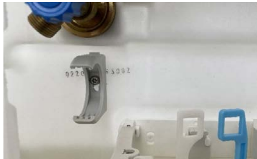
Halter für Batteriemodul mit beiliegender Schraube befestigen.
