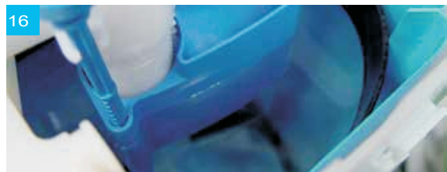
Wasserstand auf Unterkante Spanning
