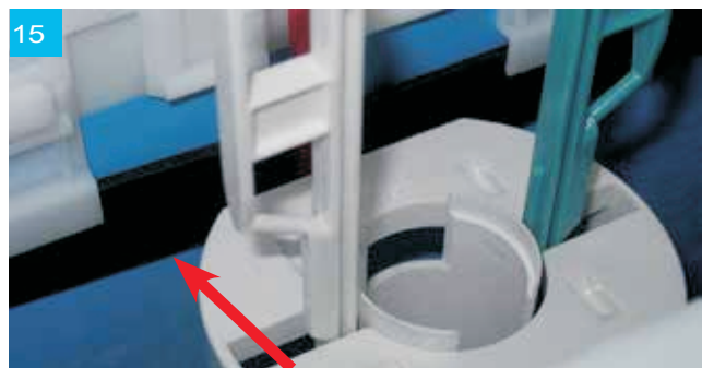
Wasserstand auf Unterkante Spanning
